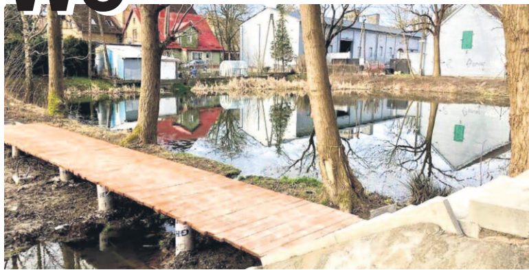
Plac budowy w okolicy kościoła św. Gertrudy.
