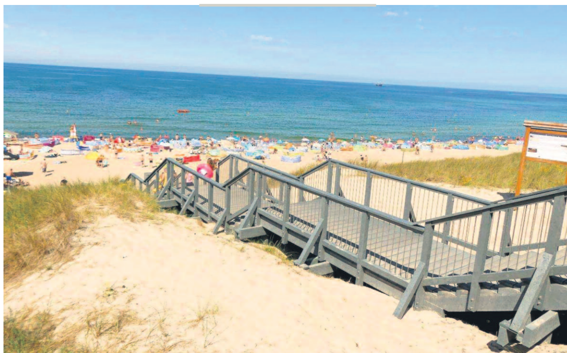
Nowe wejście na plażę przy ul. Sosnowej.
