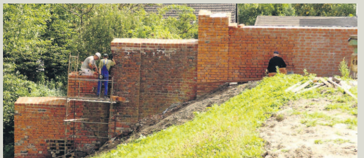
Prace nad renowacją historycznego muru obronnego w ramach projektu Darłowo w czasach Króla Eryka. Zmiana otoczenia zamku kosztuje ponad 725 tys. zł, połowę finansuje UE.
