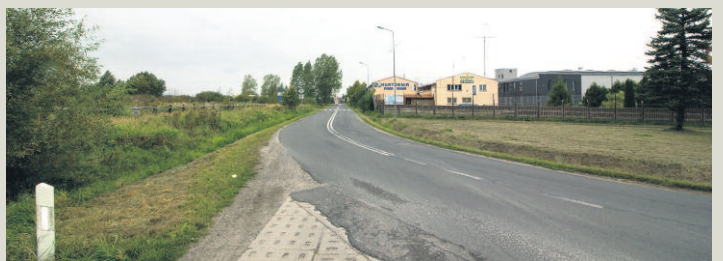
Wzdłuż ul. gen. Józefa Sowińskiego – od ul. S. Wyspiańskiego do ronda przy ul. A. Mickiewicza (wyjazd na Dąbkę) powstanie ścieżka rowerowa i chodnik oraz przeprowadzona zostanie naprawa nawierzchni asfaltowej.
