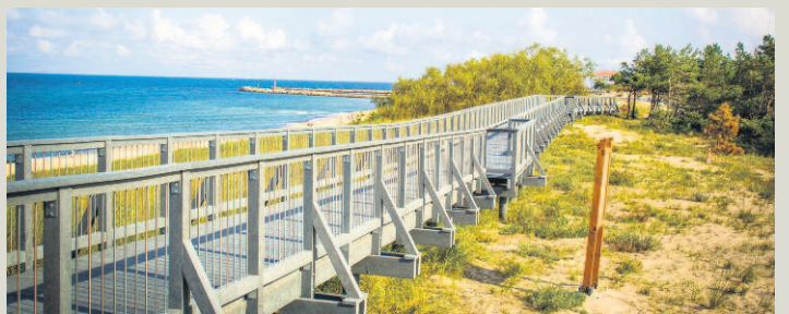
Widok na budowaną promenadę spacerową na koronie wydmy w Darłównu Zachodnim. To ostatni etap prac. Pod koniec października obiekt udostępniony zostanie mieszkańcom i turystom. Budowa kosztowała ponad 3 mln zł, połowę finansuje UE.
