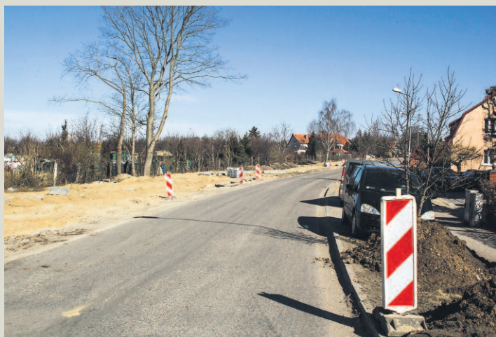
Trwają prace modernizacyjne na trasie DW 203
