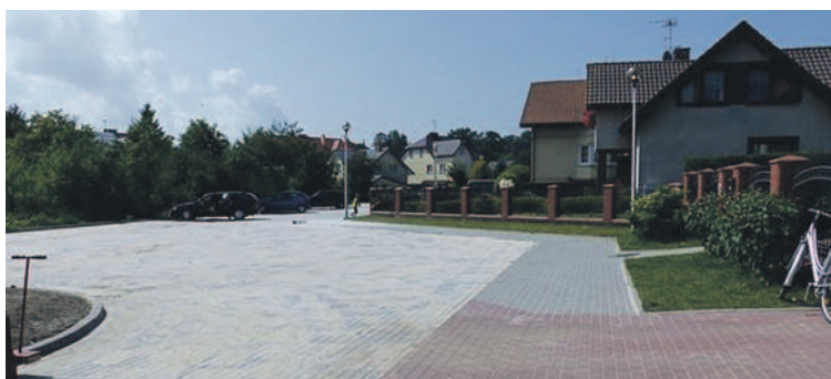
W Darłowie 25 lipca 2016 zakończono II etap budowy - nawierzchni jezdni, chod- ników i parkingu przy ul. Gen. Stanisława Maczka.
