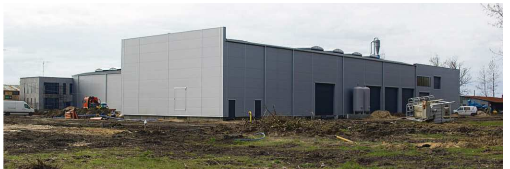
Budowa fabryki domów mobilnych Lark przy ul. Gen. Sowińskiego
