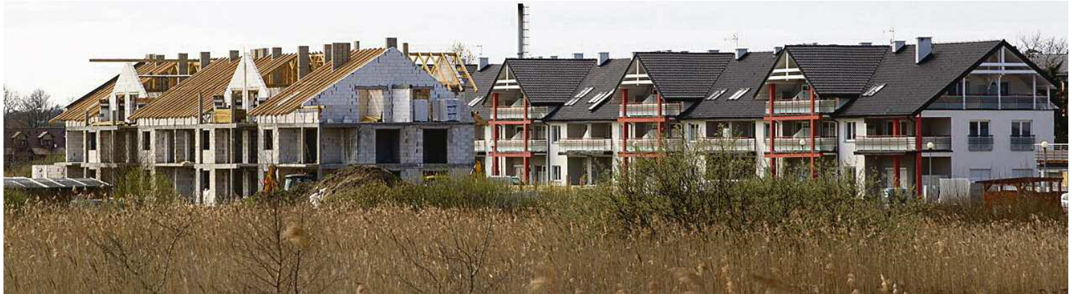
Kompleks mieszkaniowy „Kropla Bałtyku” przy ul. Północnej w Darłównu Wsch.
