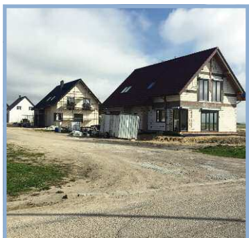
Nowe domy przy ul. Księżnej Zofii...
