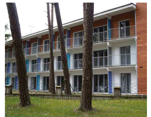
Modernizacja Ośrodka Wczasowego „Posejdon”
