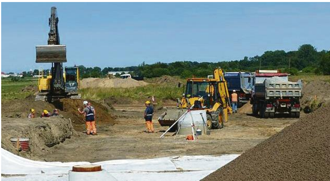
Zakończenie inwestycji zaplanowano jeszcze w tym roku.
