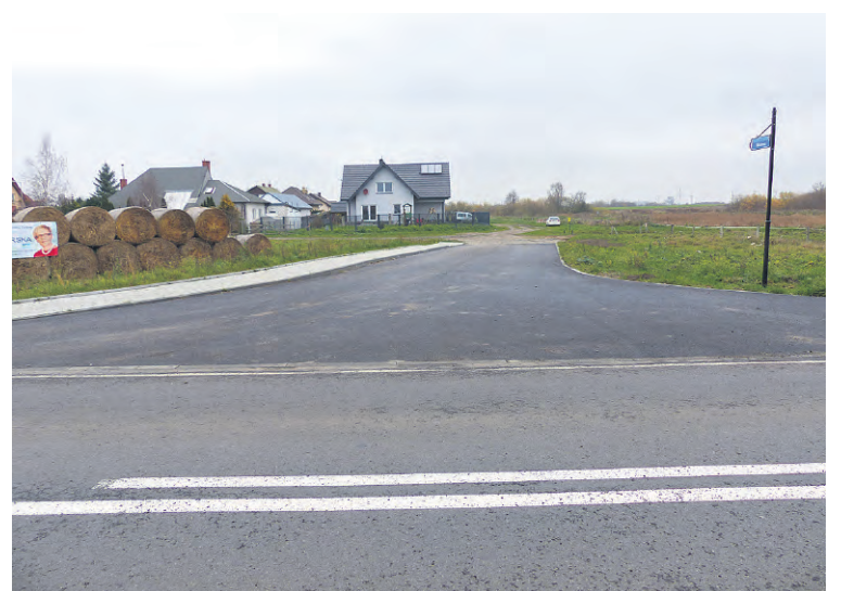
Zrobiono nowy zjazd z ul. Leśnej na ul. Wiśniową.
