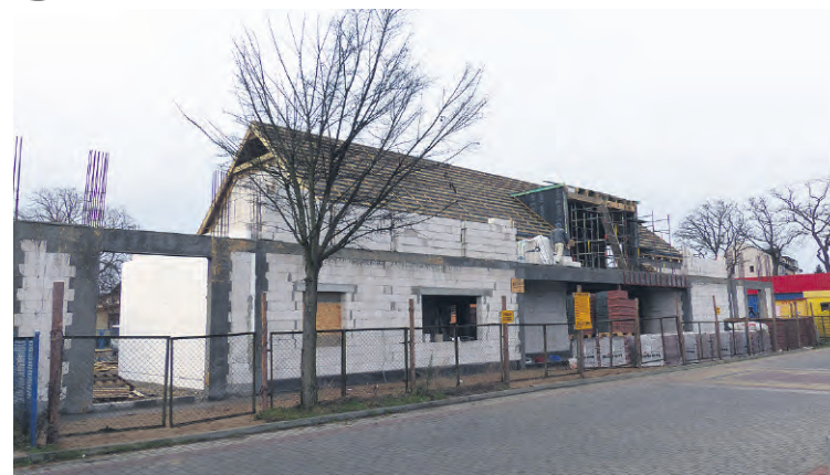
Trwa budowa terminala odpraw granicznych w Darłównu Zachodnim.
