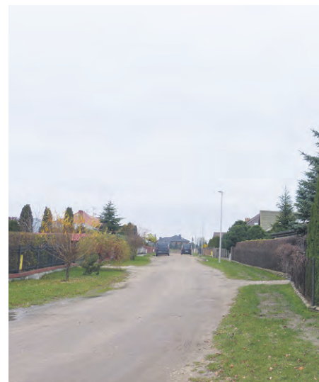
Świecą już nowe lampy na ul. Wierzbicy.
