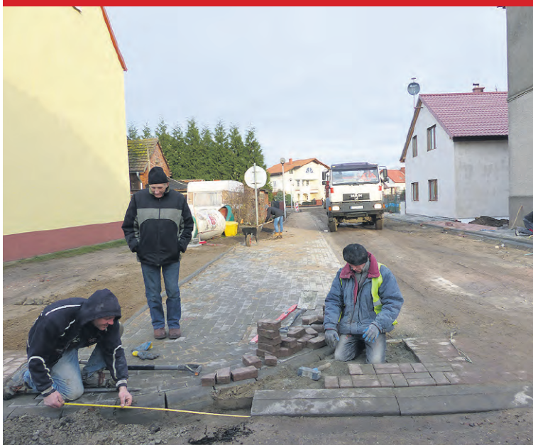
Przy ul. gen. Maczka finiszują prace przy budowie chodników.
