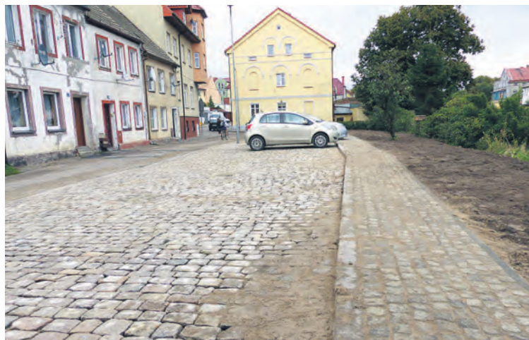
Trwają prace wykończeniowe przy budowie ciągu pieszo-jezdnego na ul. Kowalskiej
