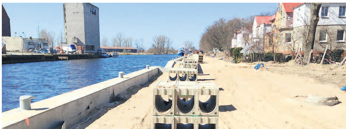
Nabrzeże przy kanale wieprzańskim. Tutaj także budowa promenady spacerowej powoli zbliża się ku końcowi. Na zdjęciu elementy chodnika.
