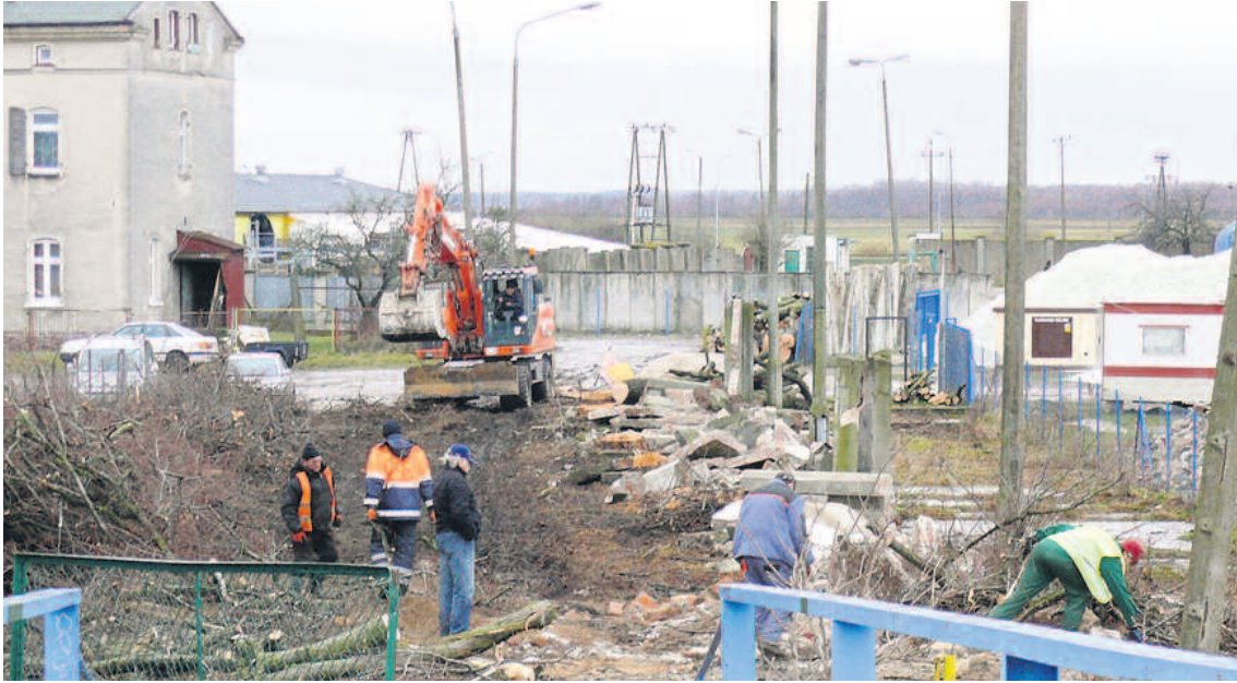
Budowa kolejnego odcinka obwodnicy rozpoczęła się przy „kładce kutrowskiej”.
