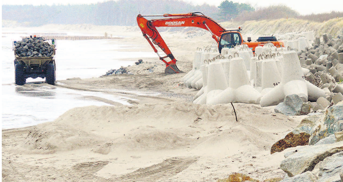
Prace ruszyły jesienią i potrwać do początku 2014 roku.
