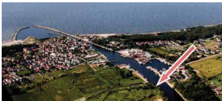
Strzałka wskazuje miejsce, w którym powstanie nowe nabrzeże. Tuż obok wykopany zostanie nowy basen portowy.
